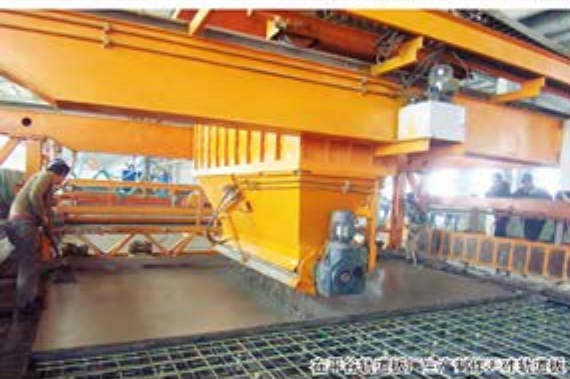
在武汉综合试验段进行无砟轨道板生产
